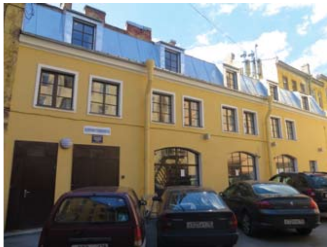
ЦТП на Литейном проспекте
