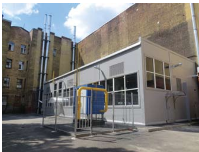
Котельная на Разъезжей улице
