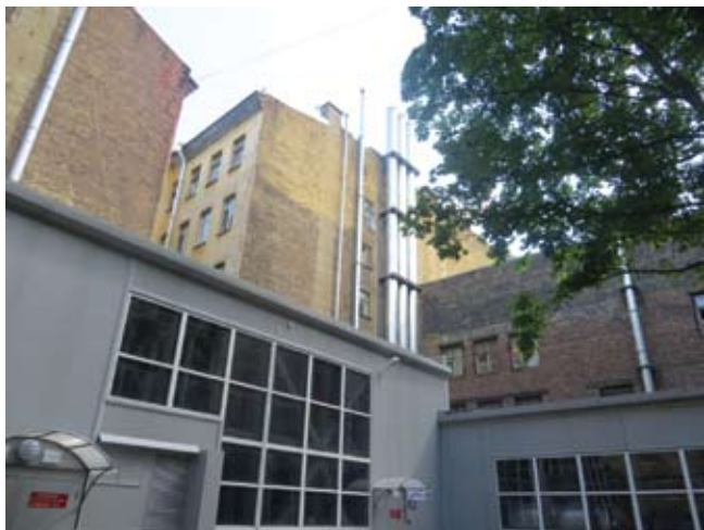
Котельная на улице Марата
